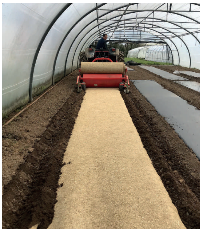
► Pose mécanique du paillage Géochanvre
