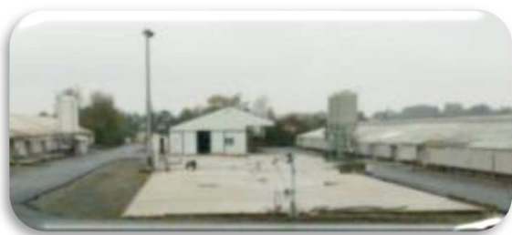
Figure 25 : Plateforme de nettoyage pour le petit matériel, au milieu de l'exploitation, avec récupération des eaux vers les fosses.
