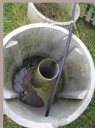
*Le fond du bac doit être bétonné, pour éviter de charger l'eau en terre et cailloux.*
