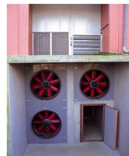
Vue de l'entrée d'air d'un échangeur en façade dans le cadre d'une ventilation centralisée par gaine basse
