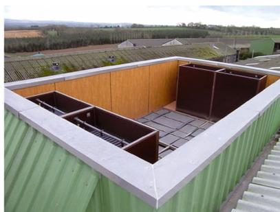
Vue de la sortie d'air d'un échangeur en toiture dans le cadre d'une ventilation centralisée par gaine haute
