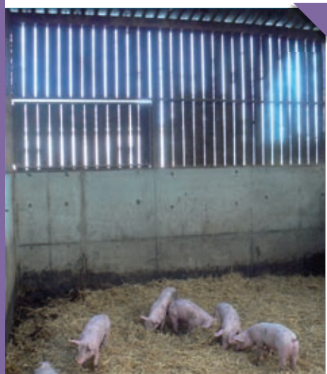
Ouvertures à claire-voies
