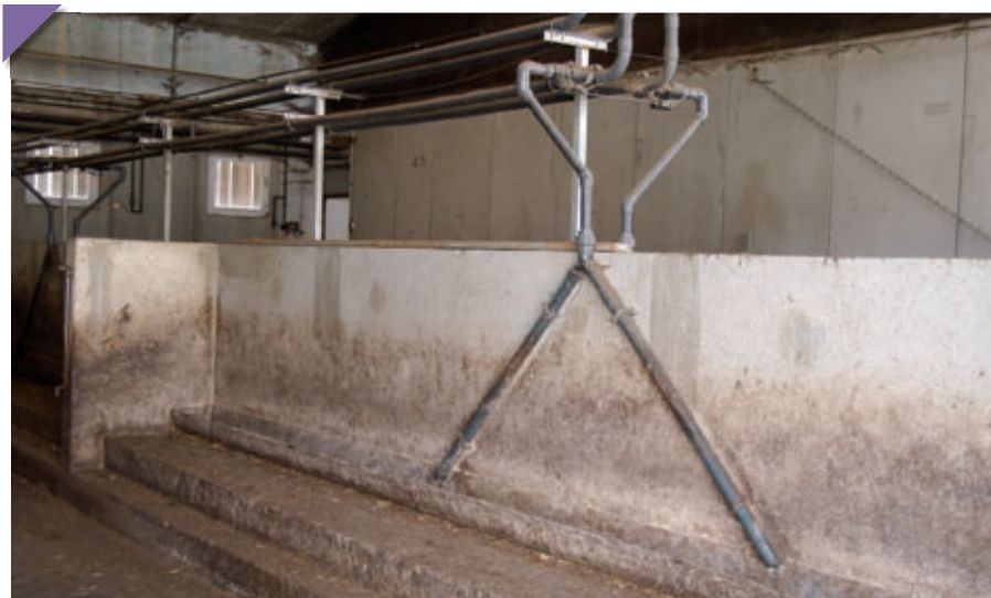
L'auge est surélevée de 40 cm par rapport au sol paillé. La petite plateforme devant l'auge facilite l'accès des porcs juste après leur arrivée, mais permet à certains de se mettre en travers devant l'auge, ce qui limite l'accès des autres.
