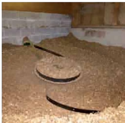
Les photos ci-dessus présentent une chaudière bois de 60 kW installée dans un élevage de porcs et le silo de stockage du bois (chauffage des maternités avec plaques eau chaude, des post-sevrages avec ailettes et de la maison d'habitation).
