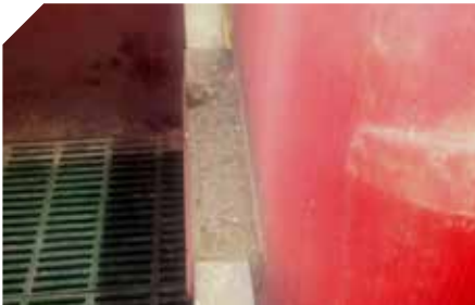
Vue du système de fixation sur la cloison de séparation de la case maternité
