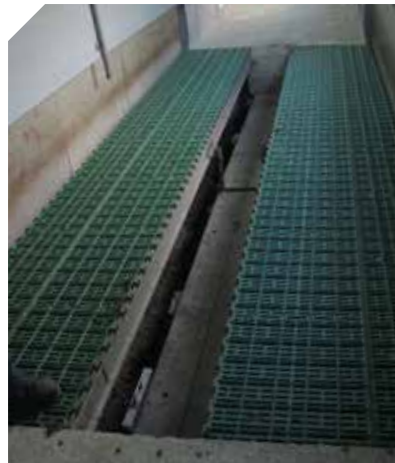
Aperçu de la fosse avec les cloisons démontées
