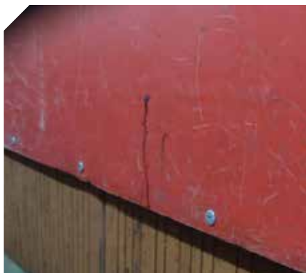
Visualisation des rivets posés dans le bas du panneau
