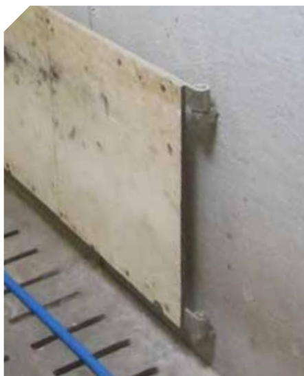
Fixé au mur, le portillon ne peut pas être renversé par les animaux
