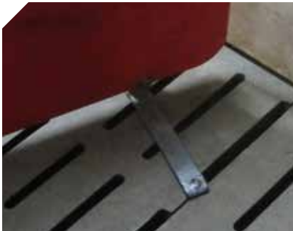
Le panneau est ancré dans les caillebotis avec des pitons
