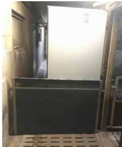
Le portillon réalisé à l'aide de cornières inox et panneaux recoupables permet de s'adapter facilement aux dimensions voulues. D'après un panneau vu à l'EARL Maquer Jean-Pierre
