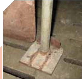
La tige s'ancre dans le caillebotis et la patte bloque le bas du panneau
