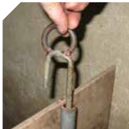
Gros plans sur le système de fixation du panneau
