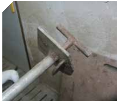
La tige s'ancre dans le caillebotis et la patte bloque le bas du panneau
