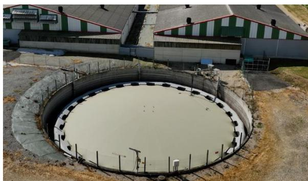
Photo 1 : La méthanisation passive consiste en une couverture de fosse captant le biogaz naturellement émis au stockage des effluents.
