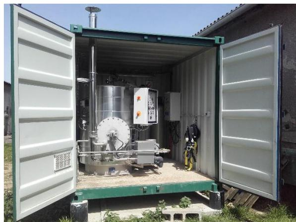
Photo 2 – Container renfermant les équipements de pilotage et de valorisation du biogaz : chaudière bi-gaz, ballon d'eau chaude et armoire électrique
