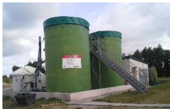
Photo 1 : Unité de méthanisation à la station de Guernevez
