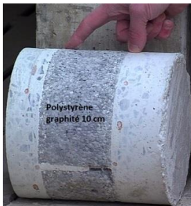
Photo 1 – Mur préfabriqué isolé avec 10 cm de polystyrène graphité installé dans la maternité AEE
