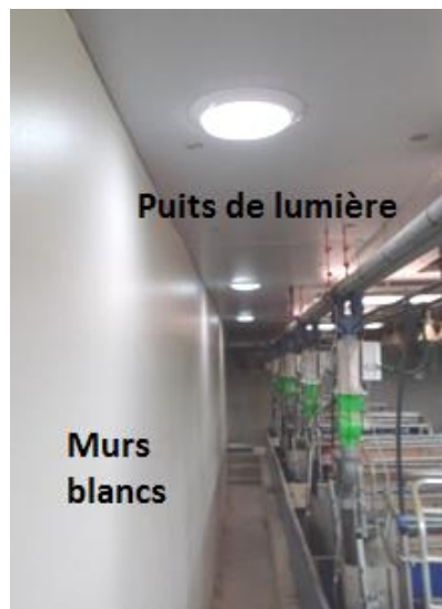
Photo 7 – Eclairage naturel optimisé par les puits de lumière et les murs blancs.
