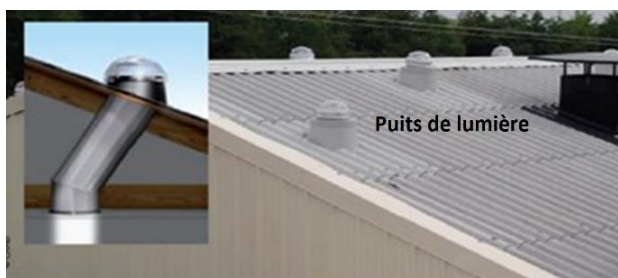
Photo 6 – Puits de lumière en toiture
