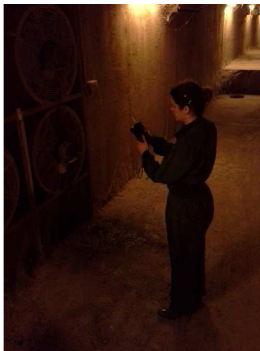
Photo 3 : Mesure de la concentration en ammoniac dans la gaine, en amont du laveur
