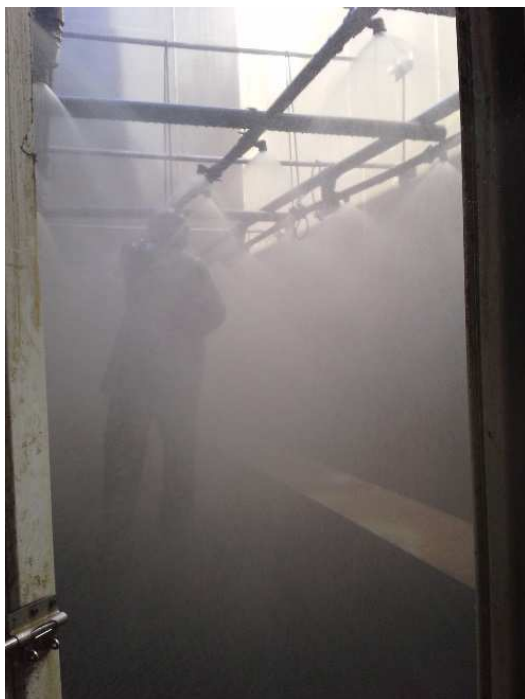
Photo 5 : Vérification du bon fonctionnement des buses d'arrosage
