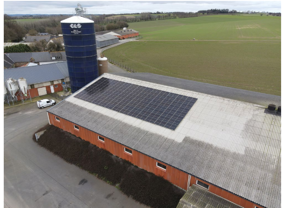
Centrale sur bâtiment porcin
