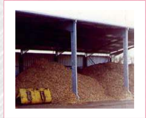
Plateforme de stockage
