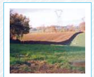
Talus anti-érosif en rupture de talweg*
