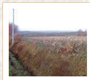
L'entretien au-dessus du talus avec épareuse
