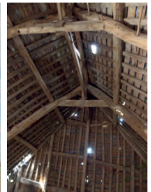
Émondage et construction traditionnelle.
