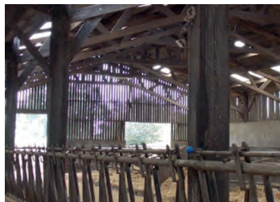
Bardage à St-Onen-la-Chapelle ( pin de l'exploitation )
