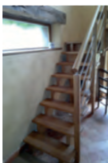
Escalier à St-Thurial ( châtaignier de la ferme )
