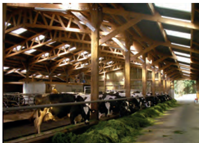
Poteaux à Kermeur ( chêne local )
