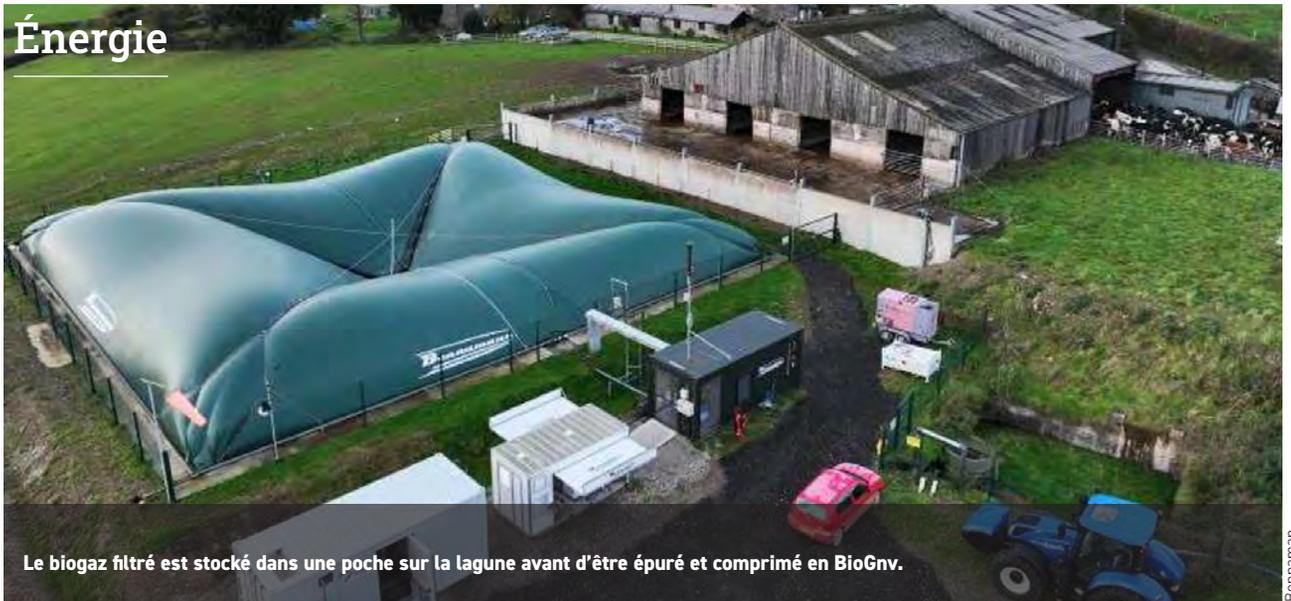
Le biogaz filtré est stocké dans une poche sur la lagune avant d'être épuré et comprimé en BioGnv.
